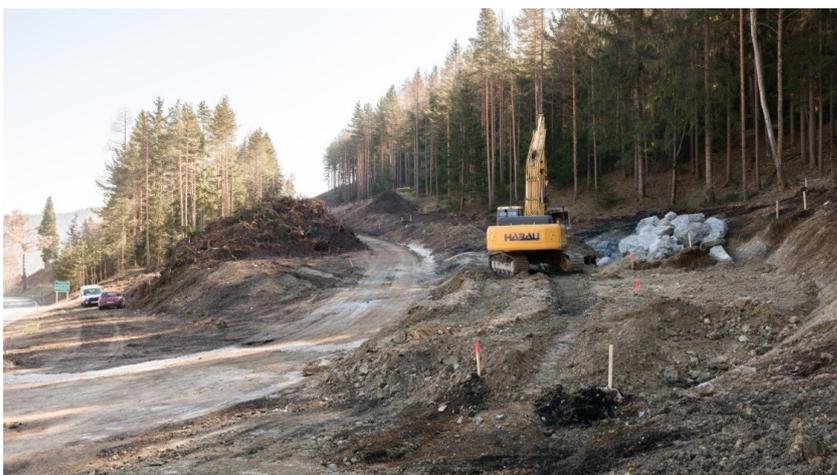
Um die Trasse möglichst schonend in die Landschaft einzubinden, wird die Straße einspurig ausgebaut und dem Gelände entsprechend in regelmäßigen Abständen mit Betriebsausweichen versehen, sodass ein gleichzeitiger Betrieb in beide Fahrtrichtungen möglich ist.
